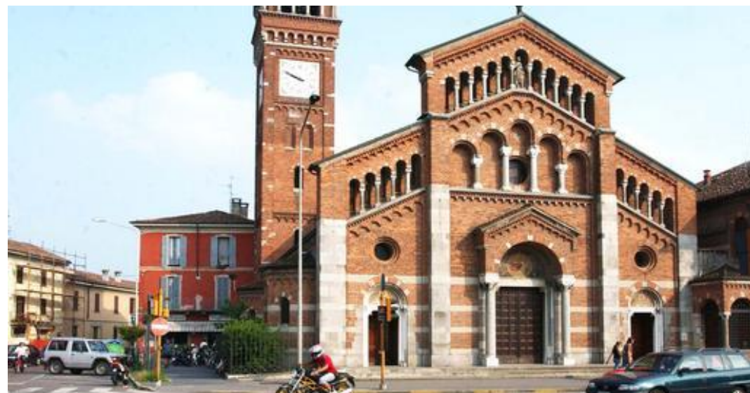
La facciata della chiesa di San Rocco in Borgo, la prima che s'incontra in città attraversando il ponte sull'Adda
